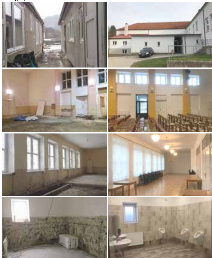
Fotografie BĚHEM a PO rekonstrukci KD
